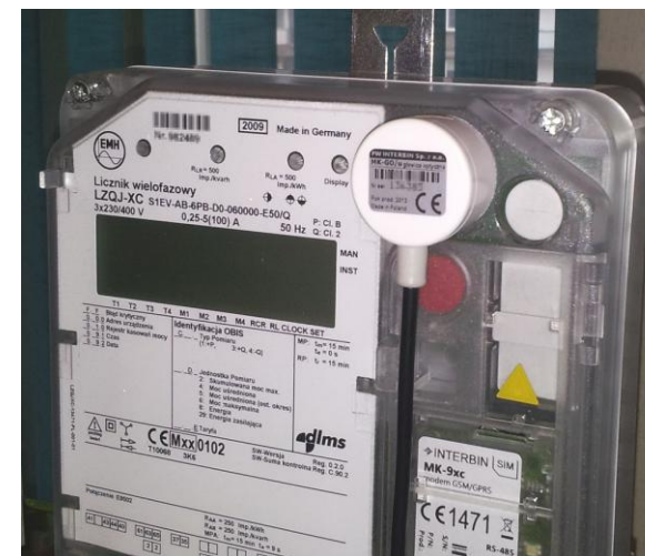
Przykład montażu głowicy na liczniku energii elektrycznej.
